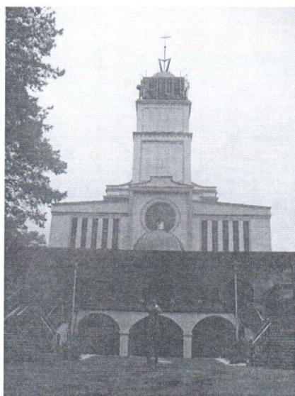
Zal. nr 1: Widok ogólny instalacji radiokomunikacyjnej.
