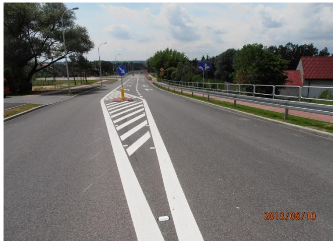
Przebudowana ul. Samsonowicza w Ostrowcu Św.
